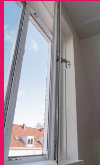
Afb. 4.3: Draairaam. Wanneer de handgreep in deze stand staat (in het midden), kan het raam open gedraaid worden.
