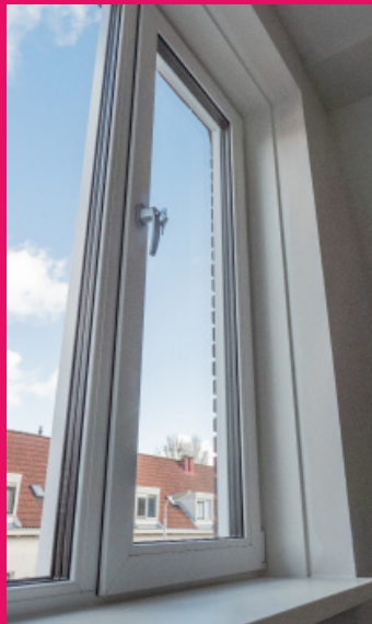
Afb. 4.1: Wanneer de handgreep in deze stand staat (naar beneden), is het raam gesloten.
