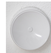
Afb. 5.6: Ventilatieventiel voor de aanvoer van schone lucht
